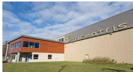
CENTRE DE TRI DE TERREBONNE
